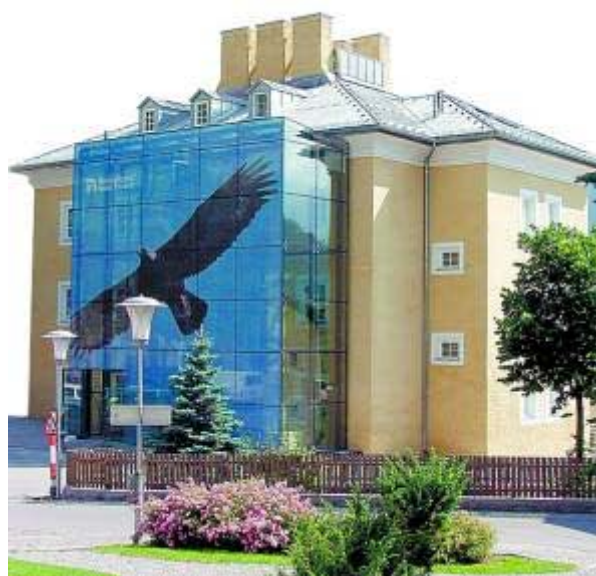
Das Nationalparkhaus in Matri hat eine erst wenige Jahre alte Ölheizung. Foto: Kohlhofer
