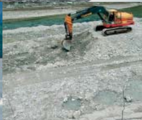
Geschiebeabtransport aus der abgeleiteten Drau >
