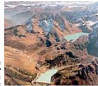
Gruppo della centrale elettrica Sellrain-Silz: i serbatoi Finstertal e Längental
